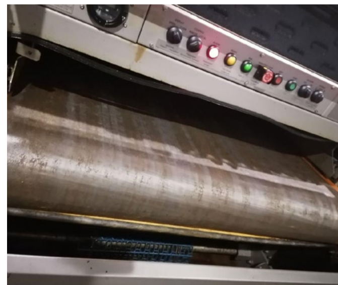
Металлическая штанга на ленточном фильтре
