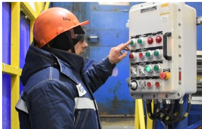
Помощник бурильщика эксплуатационного и разведочного бурения скважин на нефть и газ 5-го разряда Евгений Макагин контролирует работу ленточного транспортера
